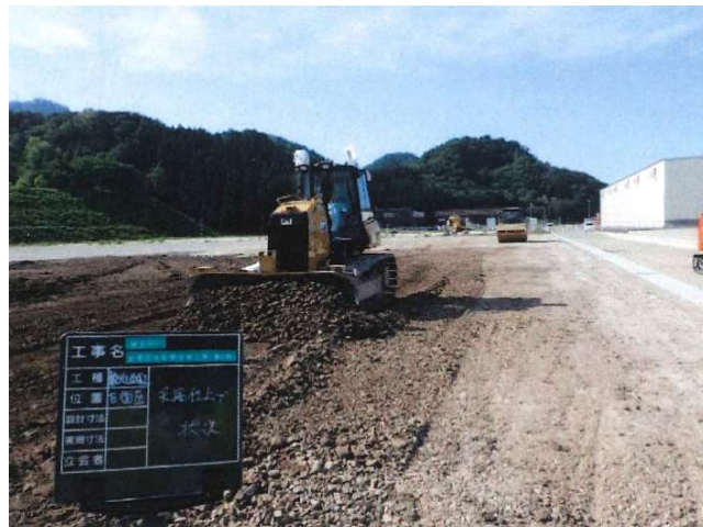
ICTブルドーザーによる敷地造成
