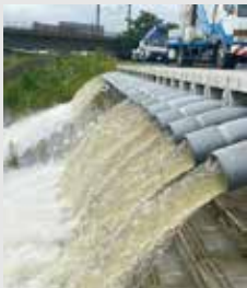
浮島(西仙北)での排水作業
