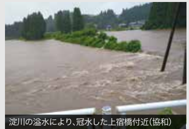
淀川の溢水により、冠水した上宿橋付近(協和)
