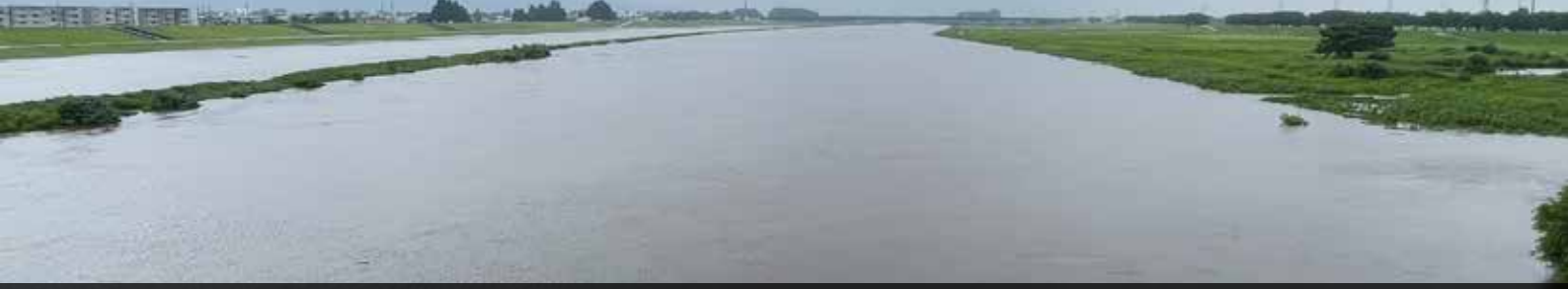
雄物川の増水により、冠水した雄物川河川敷(大曲)
