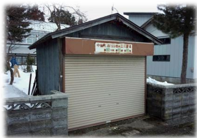
中仙支団第3分団2部3班消防格納庫
