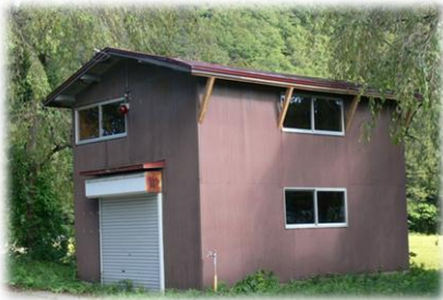
西仙北支団第3分団消防格納庫（市道）
