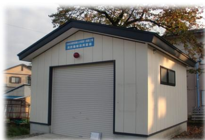
大曲支団第6分団1部2班消防格納庫
