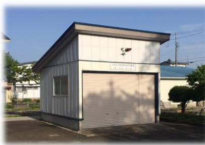
太田支団第3分団3班消防格納庫
