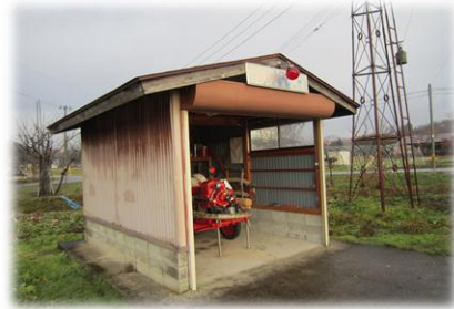
大曲支団第5分団2部3班消防格納庫
