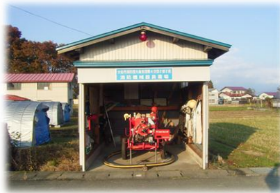
大曲支団第4分団2部2班消防格納庫
