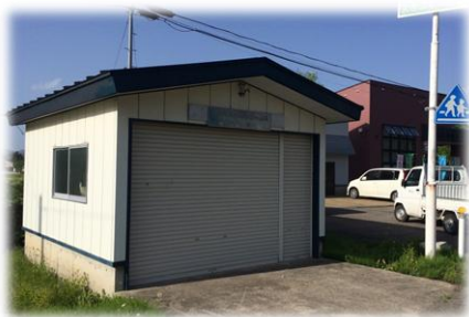
太田支団第1分団3班消防格納庫
