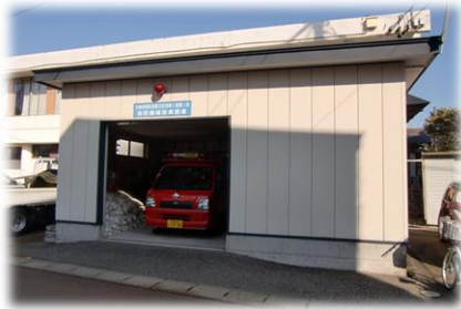
大曲支団第2分団1部1班消防格納庫
