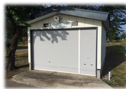
太田支団第4分団3班消防格納庫
