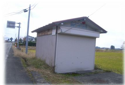
中仙支団第5分団2部1班消防格納庫
