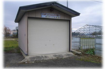
中仙支団第2分団1部3班消防格納庫
