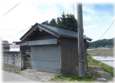
南外支団第1分団1部消防格納庫（金屋）
