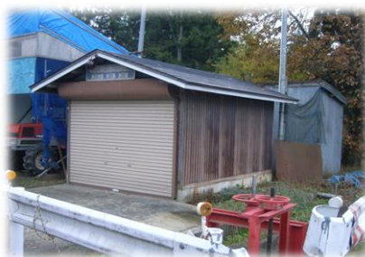
中仙支団第4分団1部3班消防格納庫
