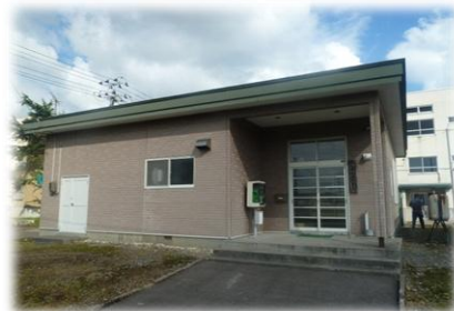
船場町市営住宅集会所
