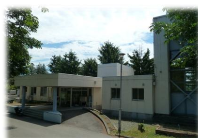
太田北部地区多目的研修センター
