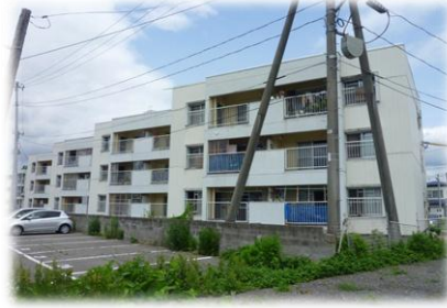
神岡A D棟市営住宅
