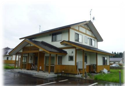
北ノ沢市営住宅
