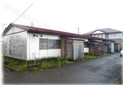
天神前市営住宅
