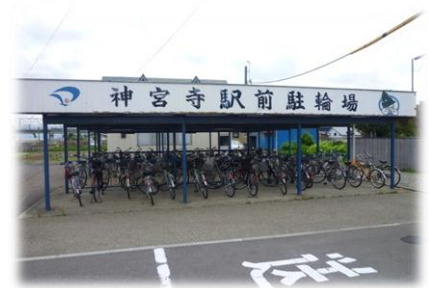
神宮寺駅南側駐車場（自転車置場）
