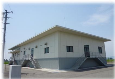
三本扇地区農業集落排水施設
