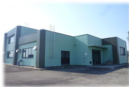
強首地区簡易水道
