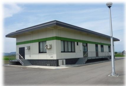
角間川地区農業集落排水施設
