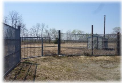
太田不燃物最終処分場
