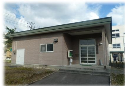
船場町市営住宅集会所
