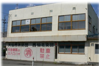
西仙北支団本部分団詰所
