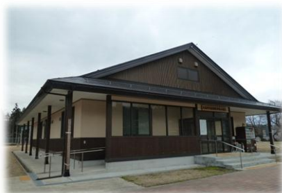
羽後境駅東集会施設
