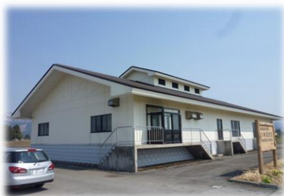
小神成地区農業集落排水施設
