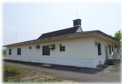
福田地区農業集落排水施設
