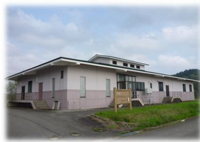
上野地区農業集落排水施設
