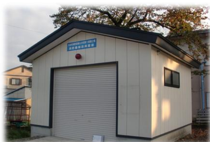
大曲支団第6分団1部2班消防格納庫
