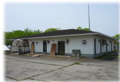
薬師地区農業集落排水施設
