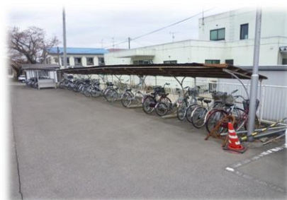
境駅前駐車場（自転車置場）
