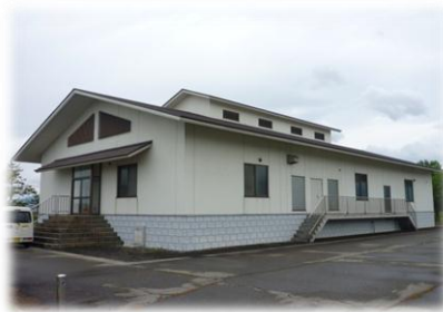
横沢地区農業集落排水施設
