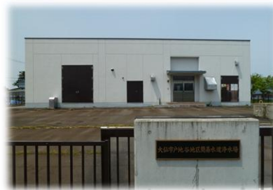
戸地谷地区簡易水道（戸地谷浄水場）
