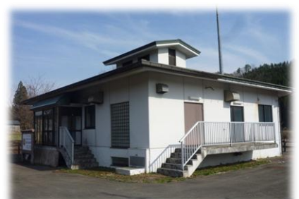
稲沢地区農業集落排水施設
