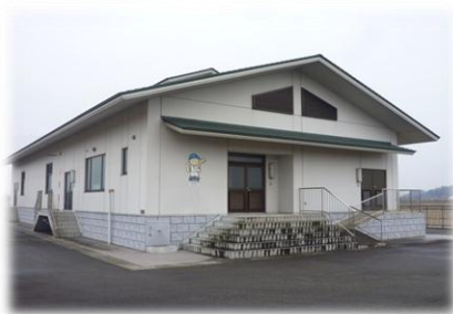
神岡東部地区農業集落排水施設
