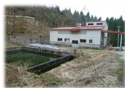
中仙一般廃棄物最終処分場
