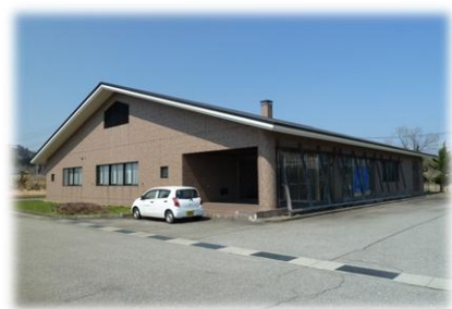
刈和野公共下水道終末処理場施設
