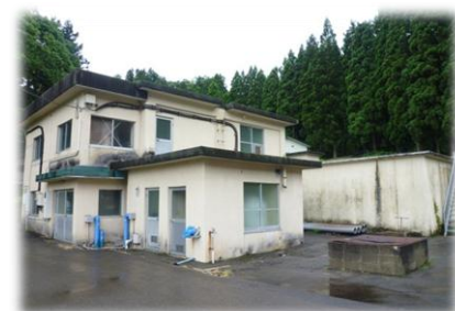
宇津台浄水場
