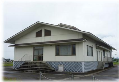
大町地区農業集落排水施設
