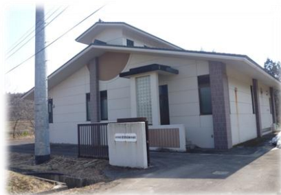
水沢地区農業集落排水施設
