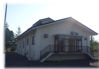
白岩地区農業集落排水施設
