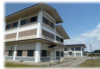
協和特定環境保全公共下水道終末処理場施設
