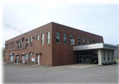
玉川第2浄水場
