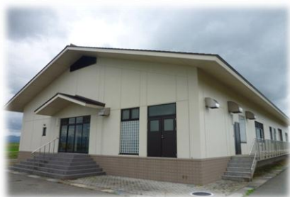
大曲西部地区農業集落排水施設
