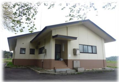
小種地区農業集落排水施設
