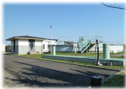
強首特定環境保全公共下水道終末処理場施設
