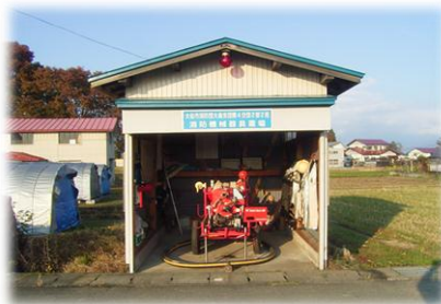
大曲支団第4分団2部2班消防格納庫
