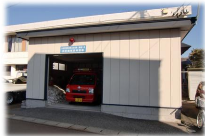
大曲支団第2分団1部1班消防格納庫
