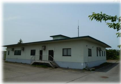
弘田地区農業集落排水施設
