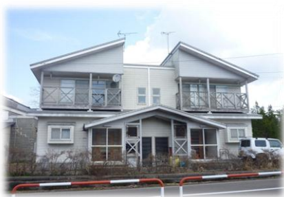
峰吉川市営住宅
