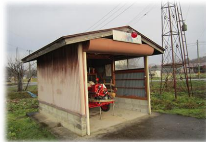
大曲支団第5分団2部3班消防格納庫
