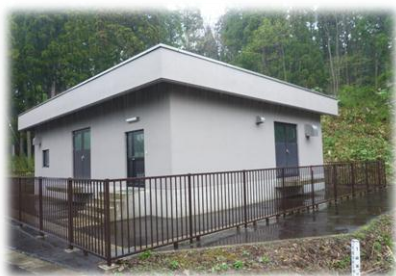
入角地区簡易水道
