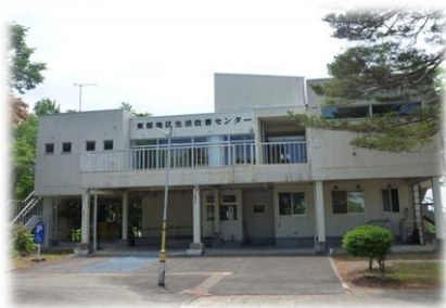
太田東部地区生活改善センター
