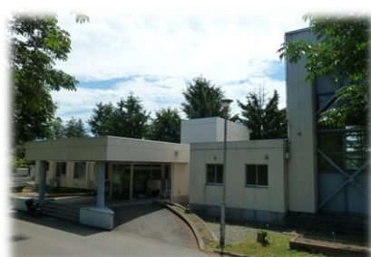
太田北部地区多目的研修センター
