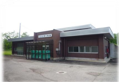
玉川第1浄水場
