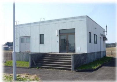
川西地区簡易水道
