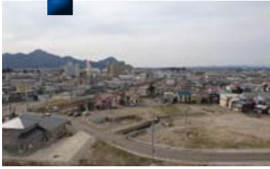
区画整理事業等で整備が進む大曲駅周辺。 (大花町都市再生住宅の屋上から)
