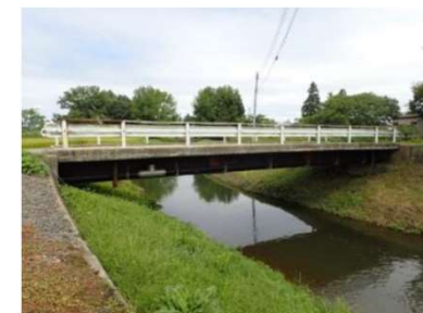
架け替え工事を実施する馬場橋
