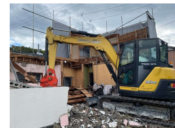
空き家解体の促進
