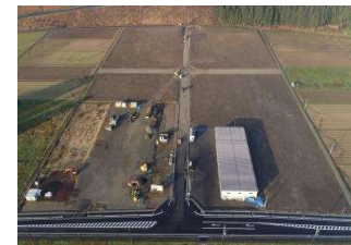
第2期企業団地造成工事
