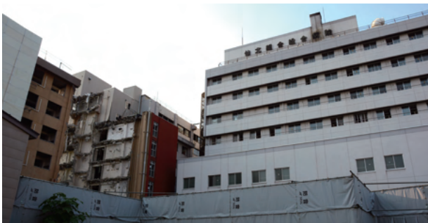
〔写真〕取り壊しが進む旧仙北組合総合病院（6月17日撮影）
