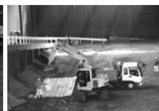
埋め立ては、主灰、飛灰固化物ごとに埋め立て箇所を区分し、処理期間内の埋め立て履歴を記録。焼却灰は50センチの敷き土の上に置き、さらに灰の上を50センチの土で覆い埋め立てた。
