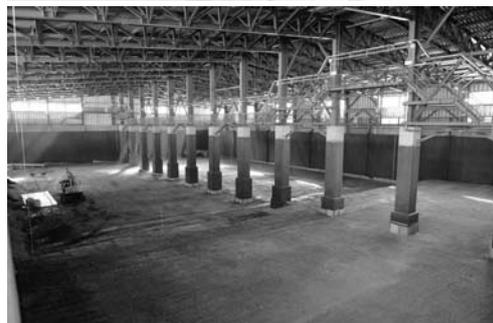
埋め立て前に、花館上大戸、下大戸、南外大向の3自治会長に、焼却灰の放射性物質濃度が焼却前の通常レベルとほぼ変わらなかったことを報告。3自治会の計約100世帯には測定結果の文書を配布し、報告。焼却灰を埋め立てる最終処分場は、埋め立て区画の底部と側部がコンクリートとアスファルトシートによる二重遮水構造で、循環式無放流システム(施設外へ水を放流しない)を採用。また、埋め立て区画上部を屋根や壁で覆い、雨水による浸出水を防ぐ。
