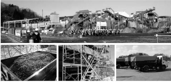
岩手県宮古市・藤原ふ頭の分別プラントから、事前調査で安全性を確認後、選別・破碎されたがれき(木質可燃性)を積み込む。積載車両左右の空間放射線量率は0.04~0.06マイクロシーベルト/hで、秋田県の通常レベル(0.03~0.09マイクロシーベルト/h)の範囲内。がれきが飛散しないようシートで覆い、車両後部の「あおり」はパッキン処理され、がれきの落下を防止。
