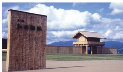
平安時代初期の役所跡といわれる国指定史跡払田柵跡
