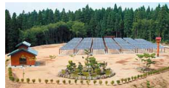
▲冬期間受光部分に雪が積もらないように角度調節ができるなど、パネルには雪国に適した工夫が施されている
