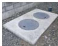
合併処理浄化槽
