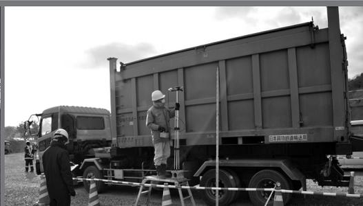
運搬トラックにがれきを積んだ後1台ずつ線量を測定
