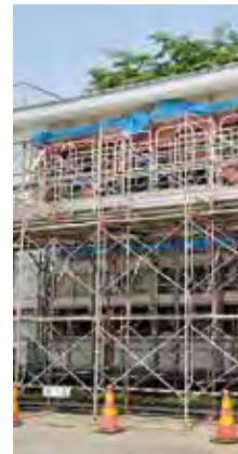
作業中は危険ですので現場に立ち入らないようにしましょう
