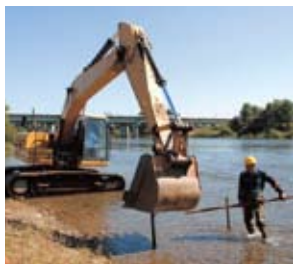
重機を使っのくい打ち作業。今年のウライ設置作業は10月2、3日実施
