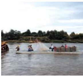
川底に取り付けられた抵抗板は浮力があり、水かさの増減に対応する
