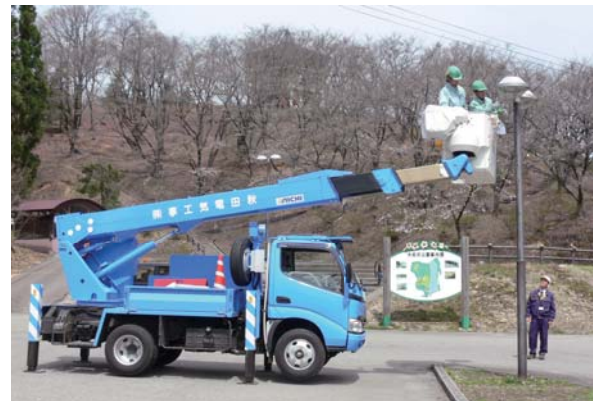
ボランティアで公園内の街灯を清掃しました。
