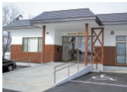
写真下 / 中仙公民館鶯野分館の正面玄関。
