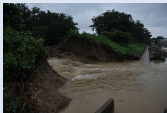
堤防が一部決壊した斉内川と洪水の様子
