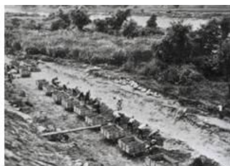
土砂運搬作業の様子(昭和8年)
