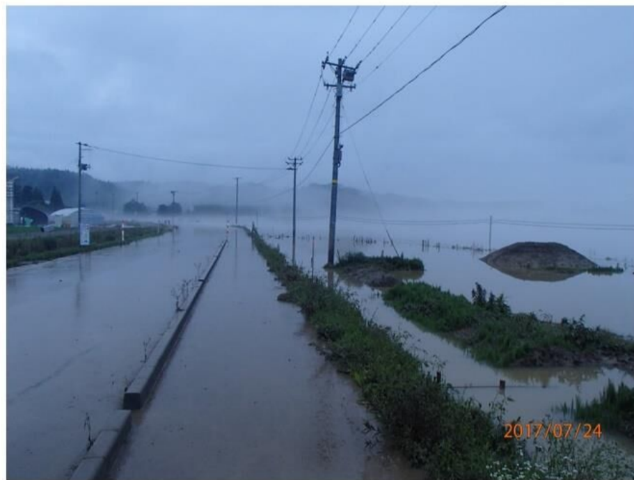
淀川保育園付近の様子（平成29年7月24日撮影）
