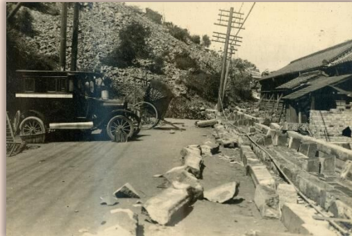
横須賀の崖崩れ
