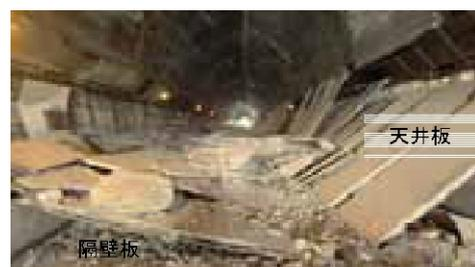
写真-4 天井板崩落状況②
