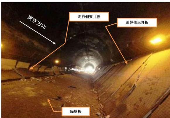
写真-3 天井板崩落状況①
