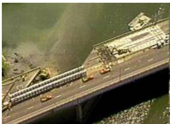
写真-1 マイアナス橋の落橋
