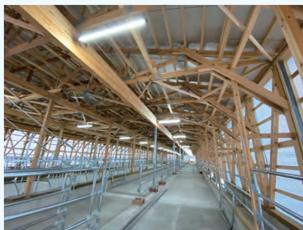
地場産材を活用した木造畜舎（中仙地域）
