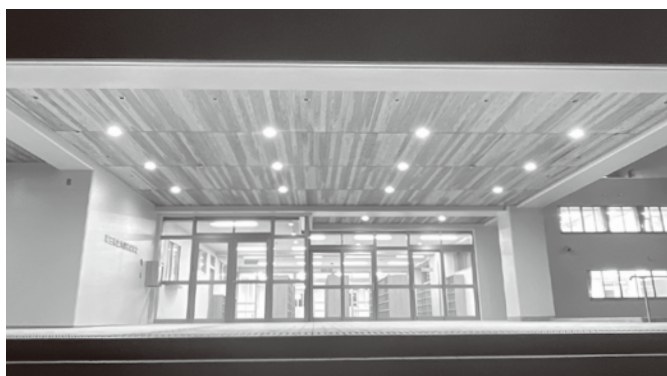
大曲高等学校校舎棟電気設備工事
