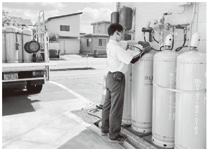
(配送業務) 訪問先にて供給設備の点検をし、ガス容器の交換作業を行います。
