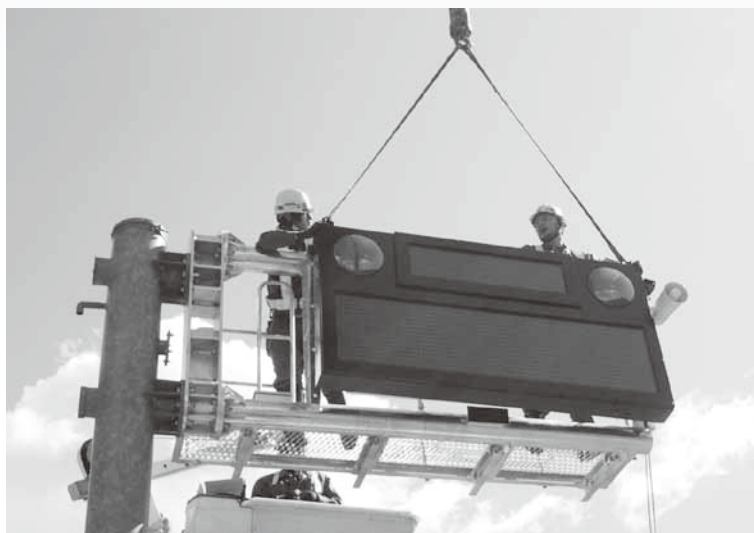
(機器取付) 様々な作業がありますが、一部の作業内容をご紹介します。
