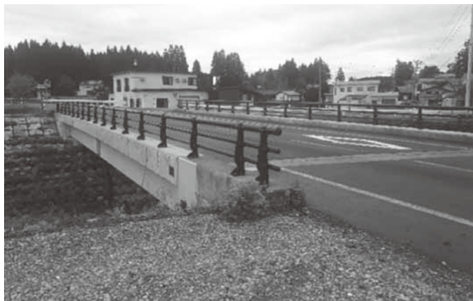
地方道路等整備工事(PC橋上部工)
