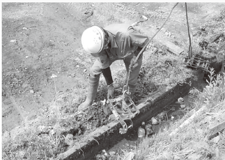
【撤去】既設用水路を撤去します。
