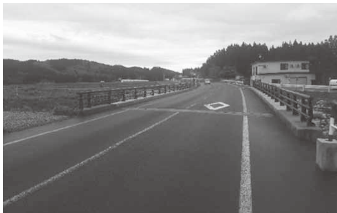
地方道路等整備工事(道路工)
