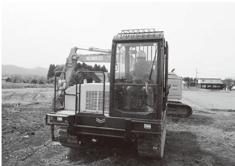
【運搬】撤去した用水路を運搬します。
