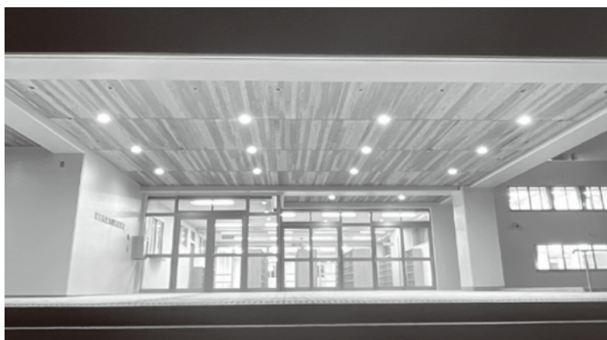
大曲高等学校校舎棟電気設備工事
