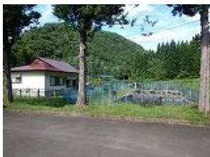
管理棟、養魚池
