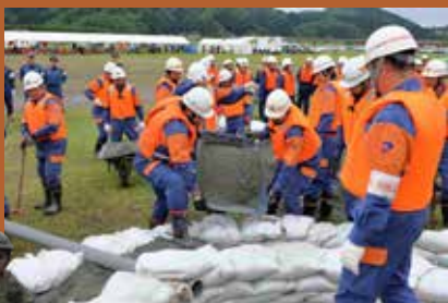
水防工法(写真左から月の輪工、釜段工)を実施する各水防団員
