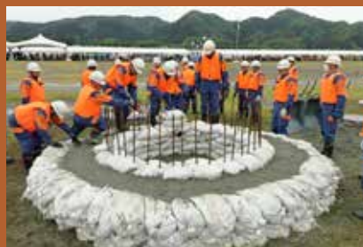
水防工法(写真左から月の輪工、釜段工)を実施する各水防団員
