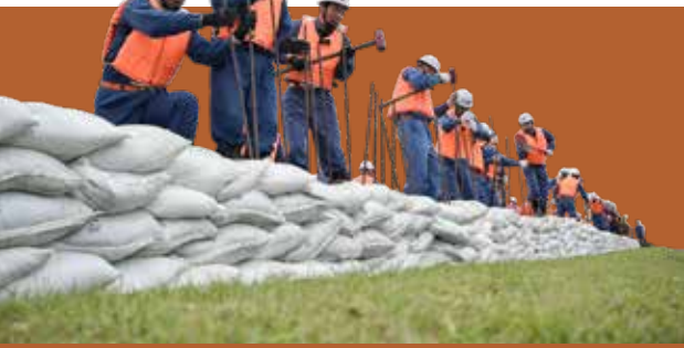
水防工法(積土のう工)を実施する各水防団員
