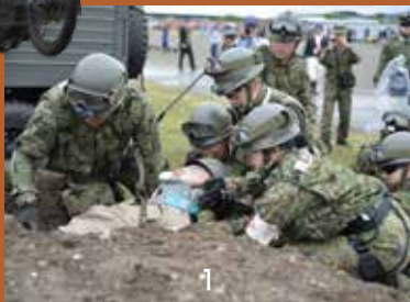
水防工法(写真左から月の輪工、釜段工)を実施する各水防団員
