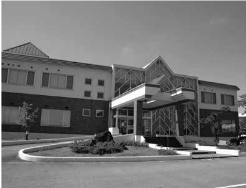
浴室棟の改修工事を行う、かみおか温泉「獄の湯」
