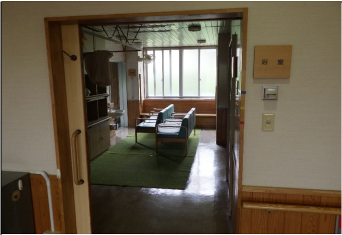
【旧デイサービス部分】浴室（脱衣所）
