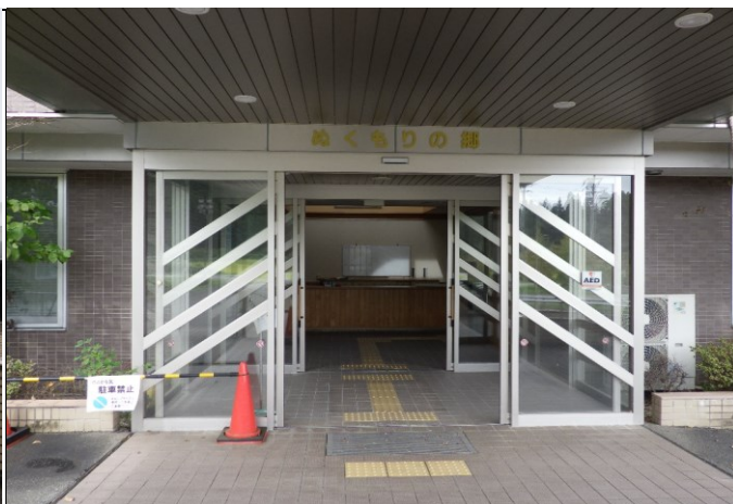
【旧デイサービス部分】入口（風防室）
