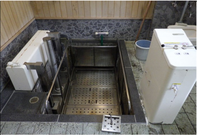
【旧デイサービス部分】特別浴室（浴槽）
