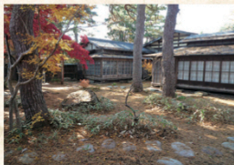
旧北島家住宅・主屋の座敷(外観)と長岡安平設計による庭園
